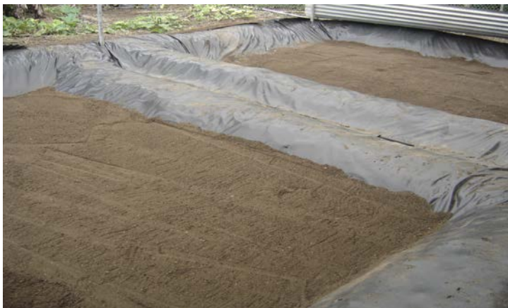
Ilustración 10 Descontaminación de los suelos (Landfarming).
