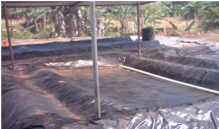
Ilustración 8 Colocación de la geomembrana en las camas de descontaminación.
