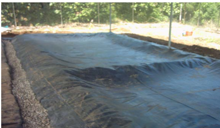
Ilustración 9 Colocación de la geomembrana en el área de acopio y tamizado del material contaminado.
