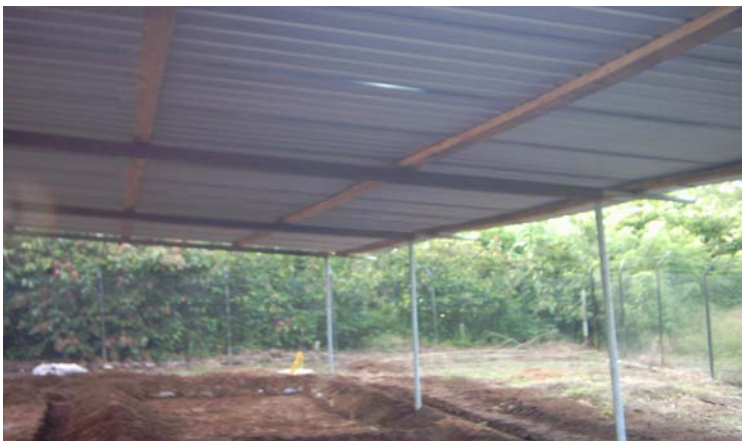
Ilustración 7 Techo metálico para el área de acopio y tamiz del material contaminado.
