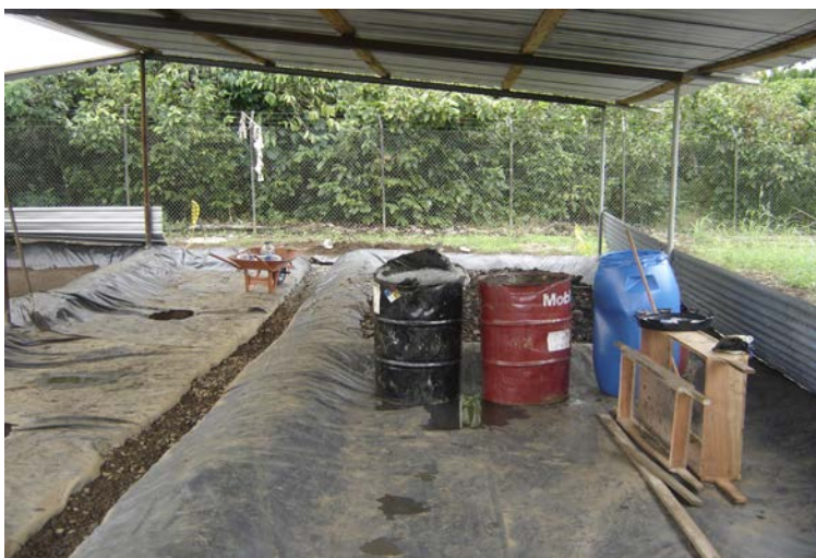
Ilustración 12 Proceso de acopio y tamiz del material contaminado.
